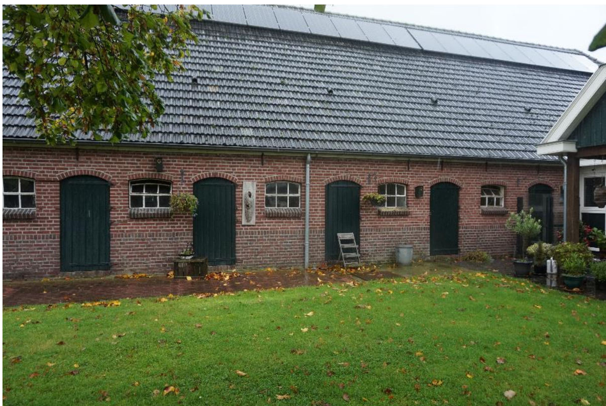
Figuur 1.5 Oostgevel schuur.
