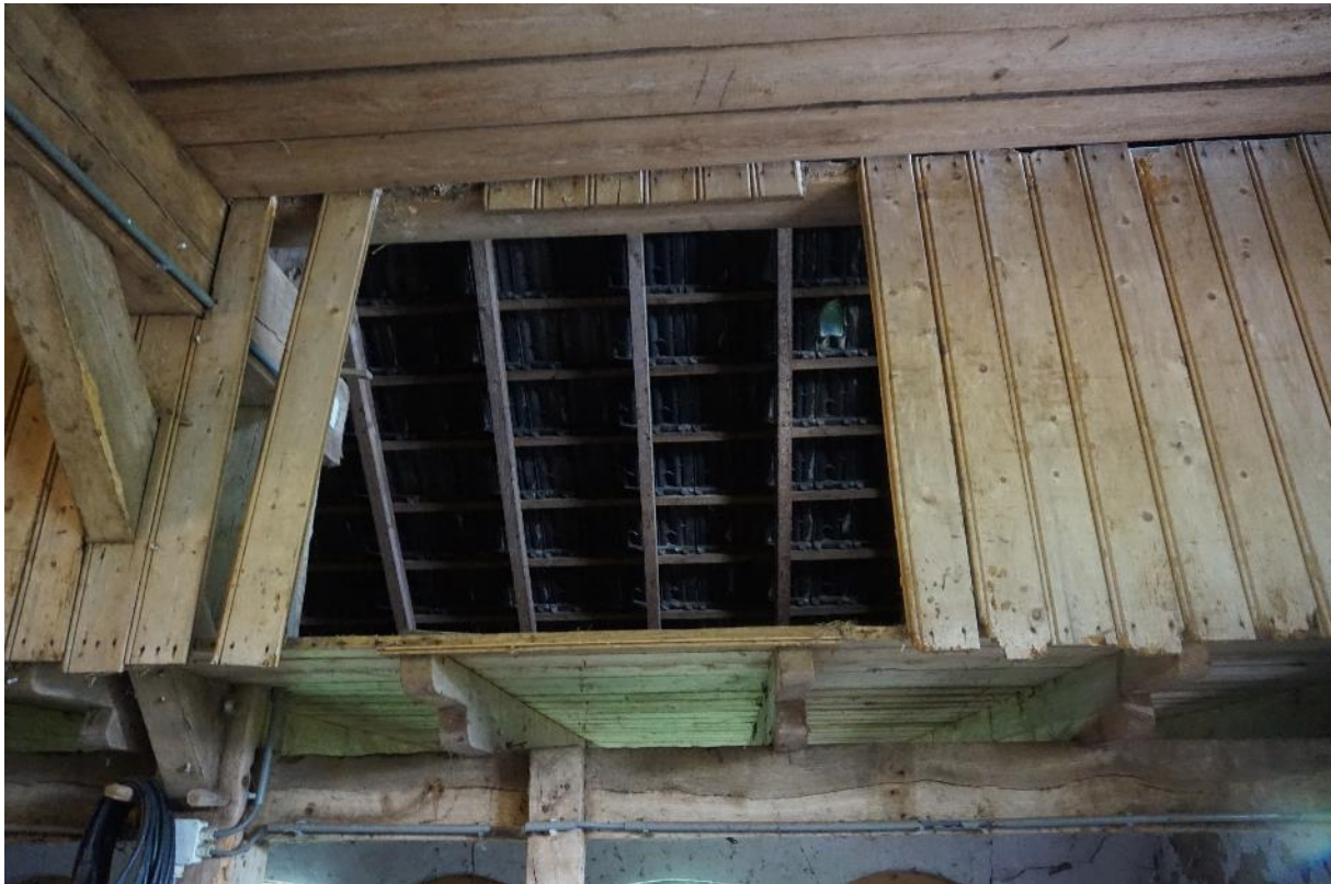
Figuur 4.3 Binnenzijde schuur, het dak is aan de binnenzijde onafgewerkt.
