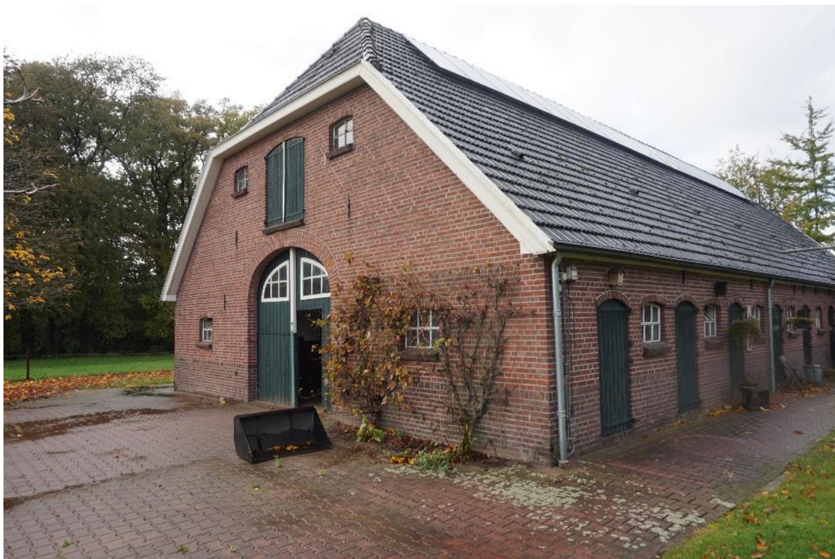
Figuur 1.2 De te verbouwen schuur.
