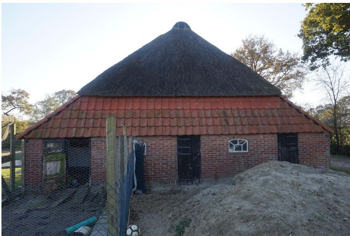
Figuur 1.3 Linkerzijgevel van de te verbouwen schuur.
