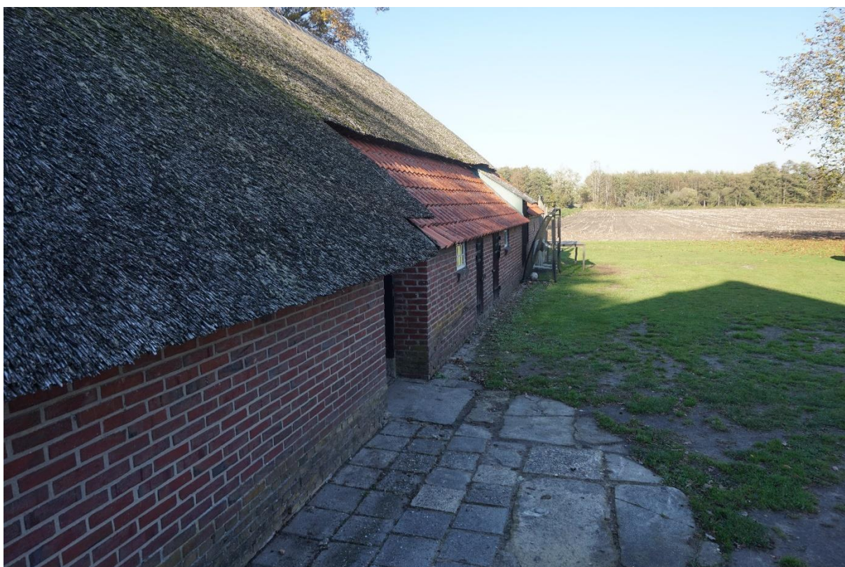
Figuur 1.5 Achtergevel van de te verbouwen schuur.
