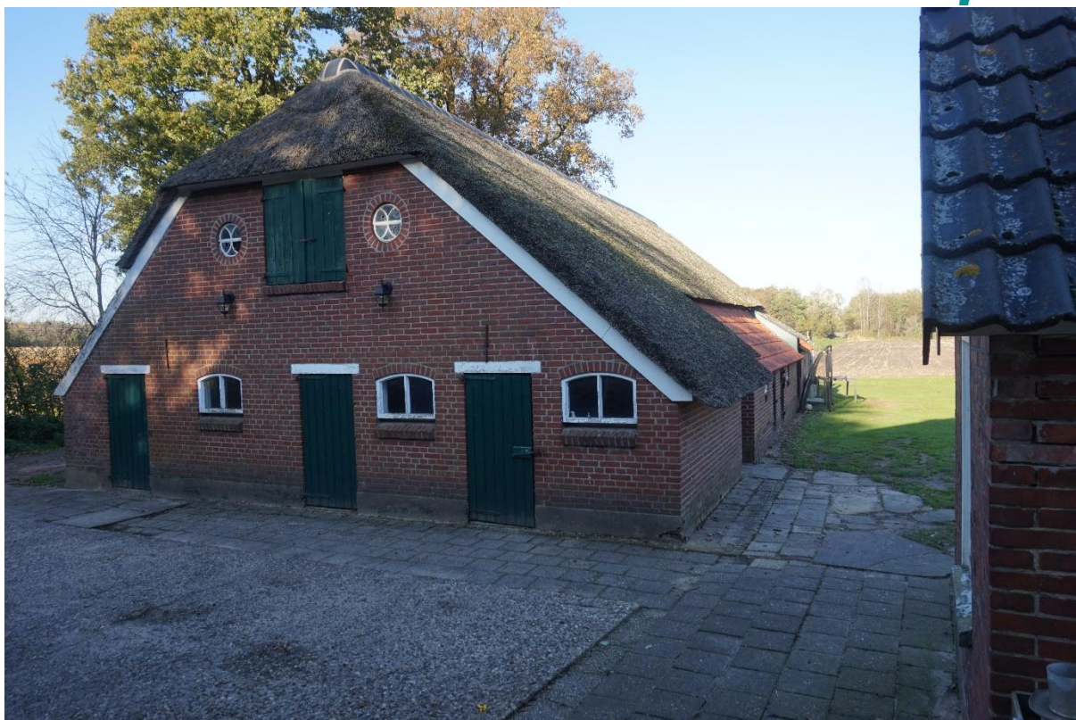
Figuur 1.4 Rechterzijgevel van de te verbouwen schuur.
