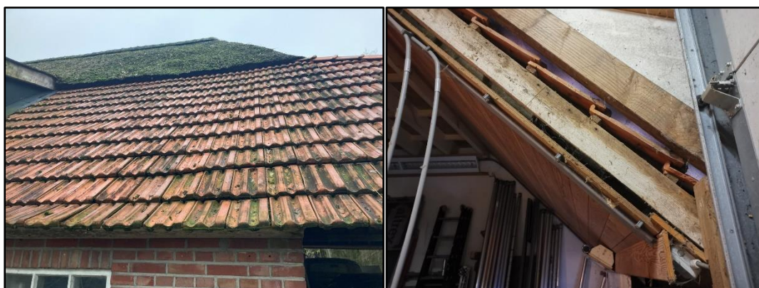
Figuur 2.5 (links): Een detail van het dak; Figuur 2.6 (rechts): De binnenkant van een dakkapel waarin de roldeur is opgenomen.
