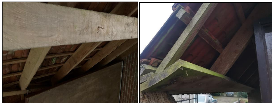
Figuur 2.7 (links): De onderkant van het dak van de overkapping; Figuur 2.8 (rechts): De onderkant van het dak aan de onderrand.
