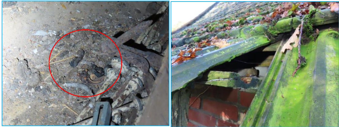
Foto's: Oude latrine en een potentiële toegang voor de steenmarter.
