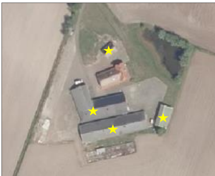
De te slopen bebouwing wordt met de gele sterren aangeduid (bron luchtfoto: ruimtelijkeplannen.nl).
