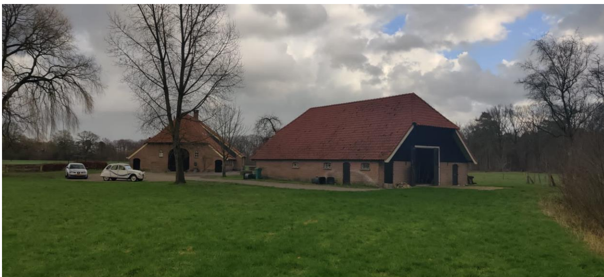
Afbeelding 3. De te verbouwen schuur, gezien vanuit het noordwesten, met in de achtergrond de bestaande woning.
