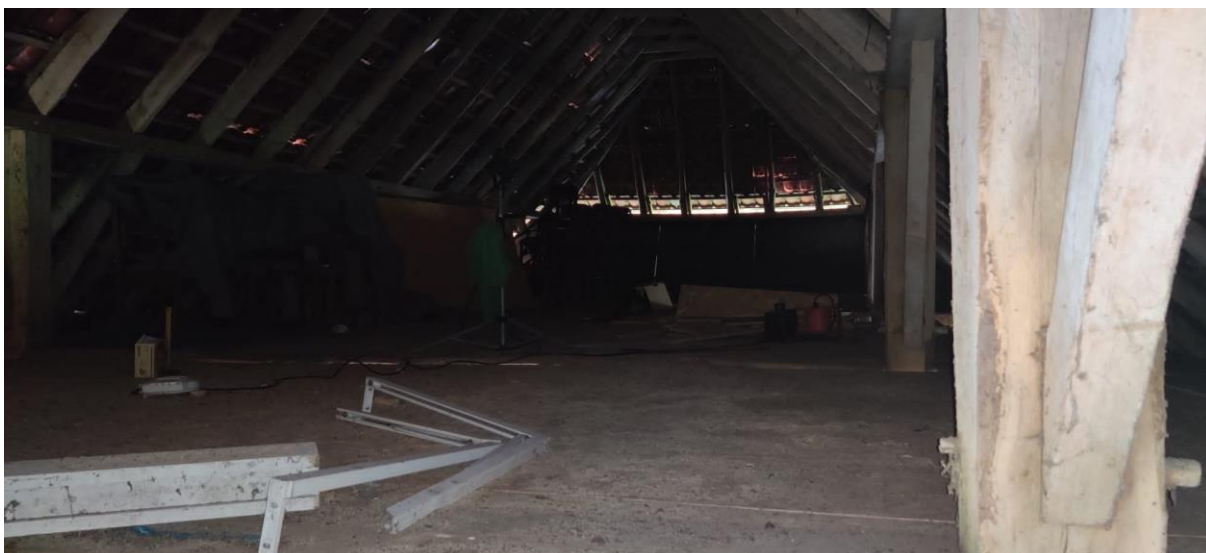
Afbeelding 6. De zolder, duidelijk is te zien dat er aan de binnenzijde geen dakbeschot aanwezig is.
