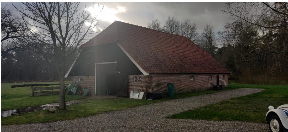
Afbeelding 4. De voorzijde van de te verbouwen schuur.
