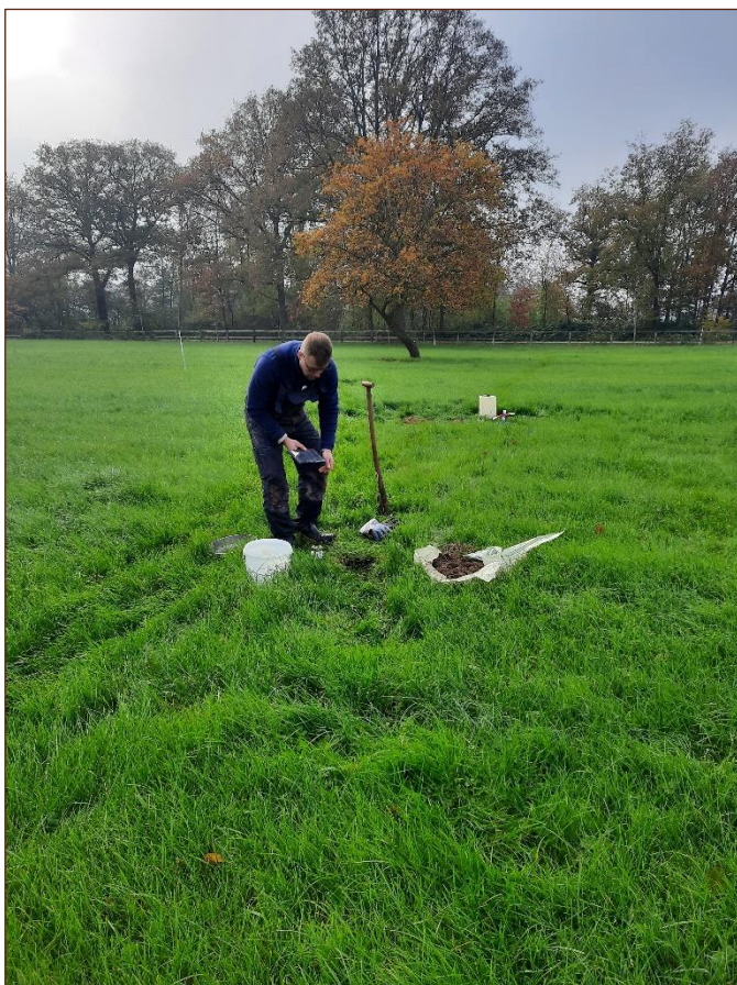
Foto 1: Situatie asbestgaten in mogelijke voormalige sloot
