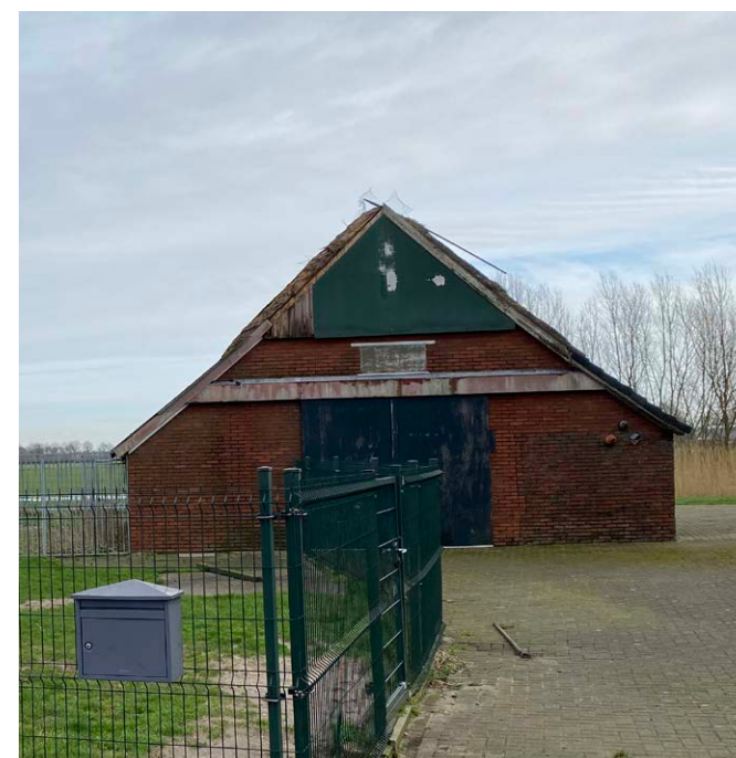
Te slopen schuren op het terrein
