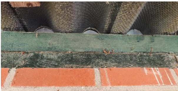
Het merendeel van de nokken onder de golfplaten zijn afgedicht.
