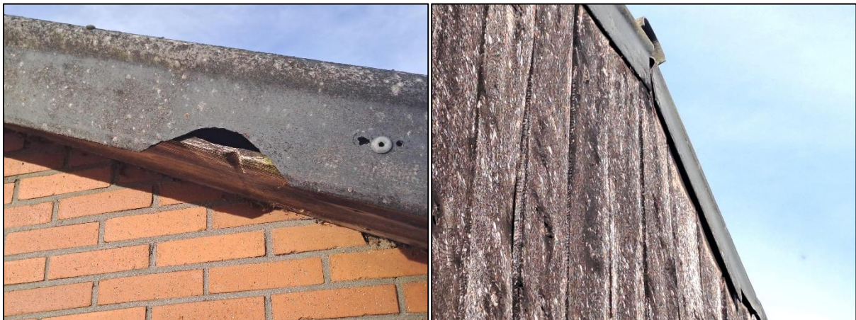
Foto's: vleermuizen kunnen door openingen en kieren in de ruimte tussen dakoverstek en gevel kruipen.
