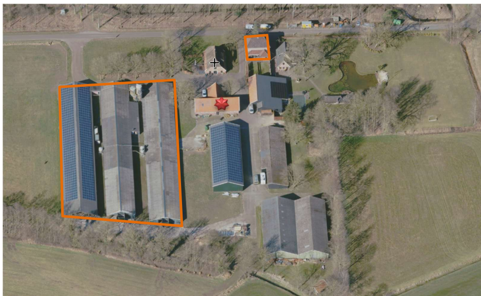
• Afbeelding 33: kolonie boerenzwaluw in de paardenstal (rood) t.o.v. sloop- en bouwlocatie (oranje)
