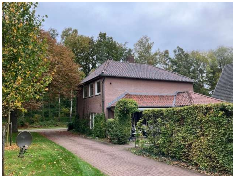
• Afbeelding 31: achtergevel woning
