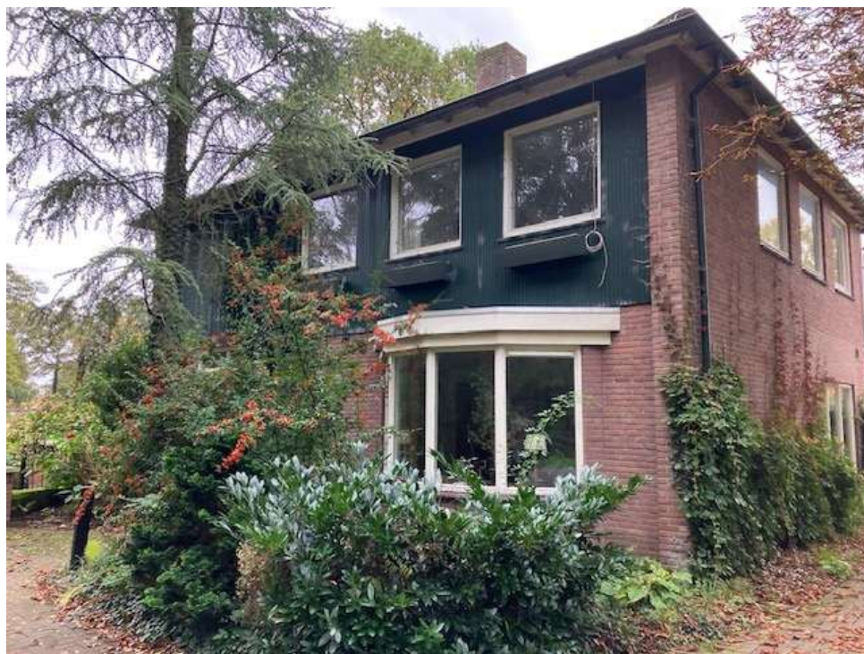
• Afbeelding 24: Te slopen bedrijfswoning
