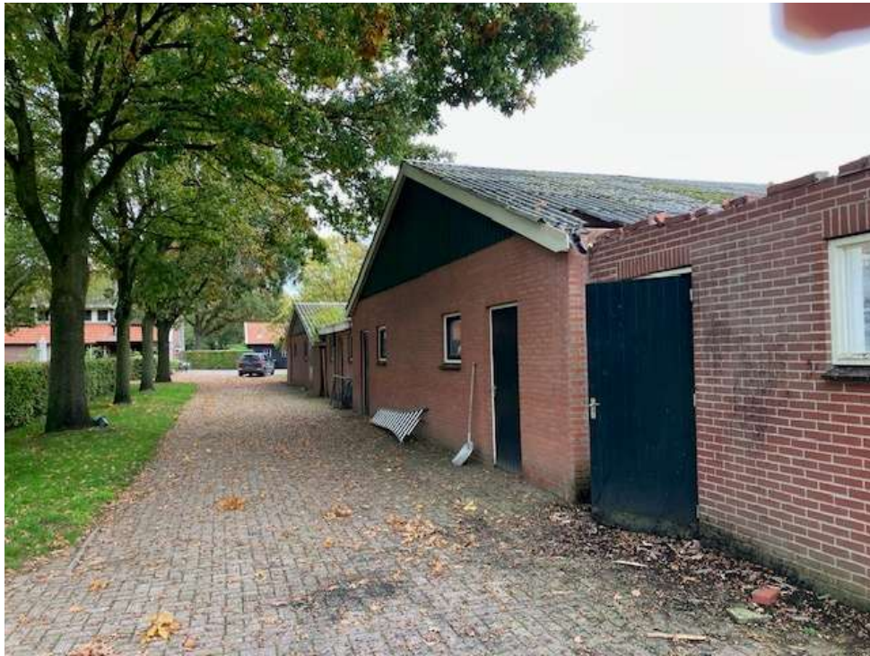
• Afbeelding 17: voorgevel te slopen stallen
