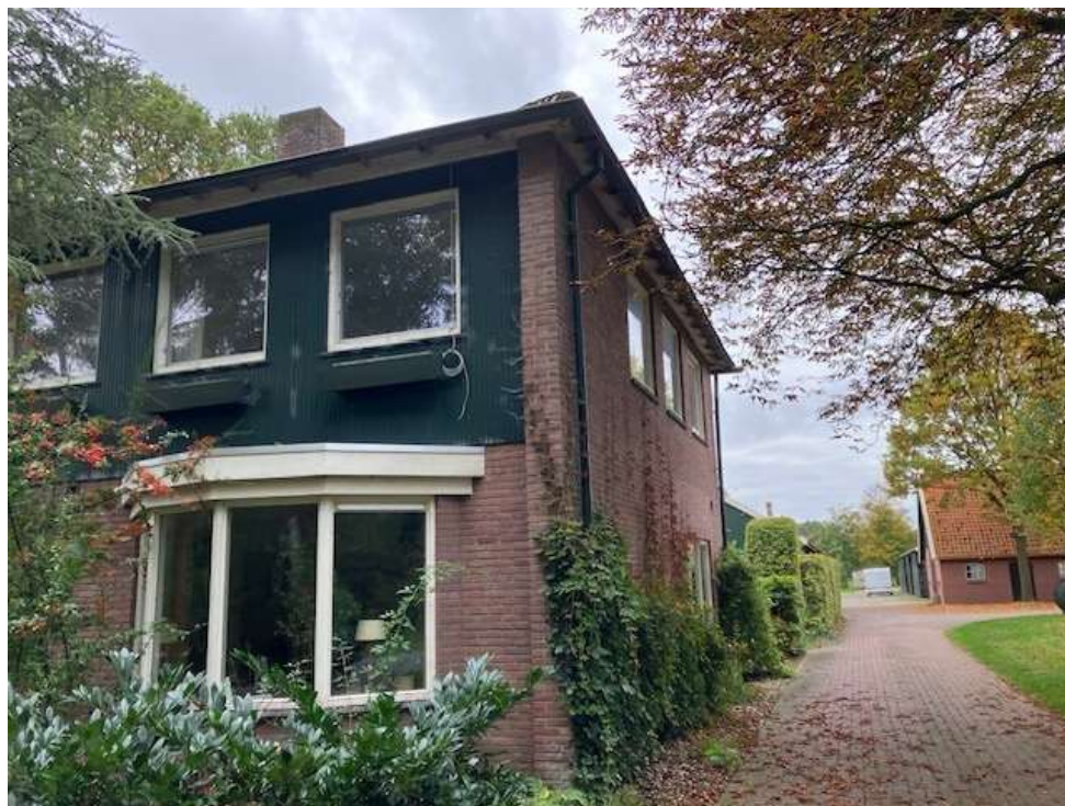
• Afbeelding 25: Zijkant te slopen bedrijfswoning
