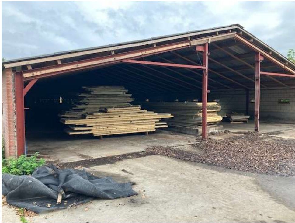
• Afbeelding 7: Schuur is al gedeeltelijk gestript
