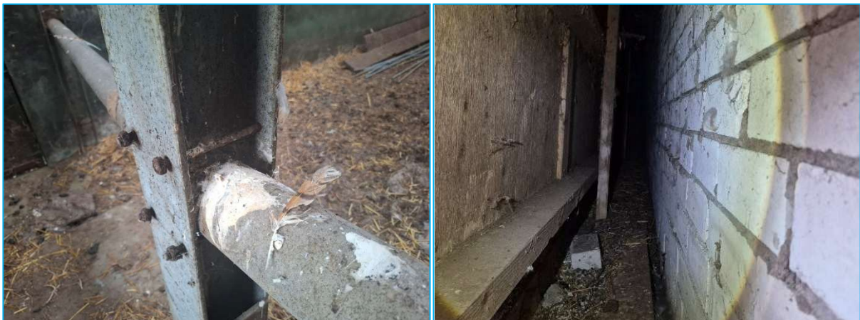
Foto's: Krijtsporen en veer van kerkuil (links) en dubbele wand met daarachter potentiële nestlocatie (rechts), in opstal 3, melkhuys.
