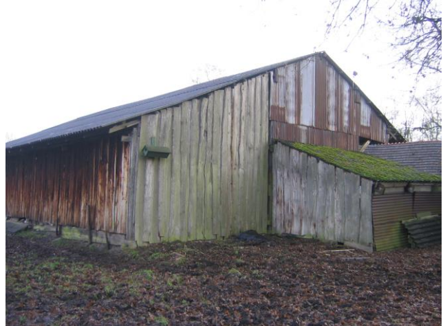
Zijkant – met achterzijde aanbouw
