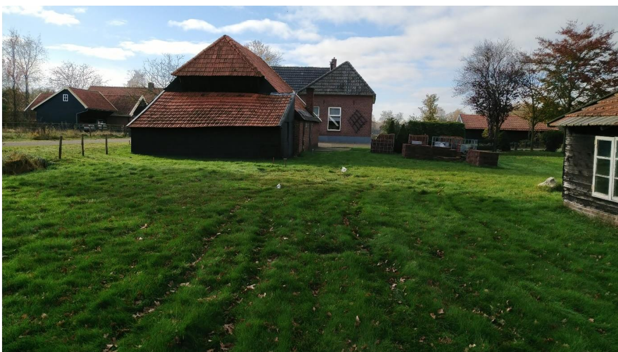
Figuur 4: Beeld van het terrein, met rechts het voormalige kippenschuurtje (situatie 10 november 2021)
