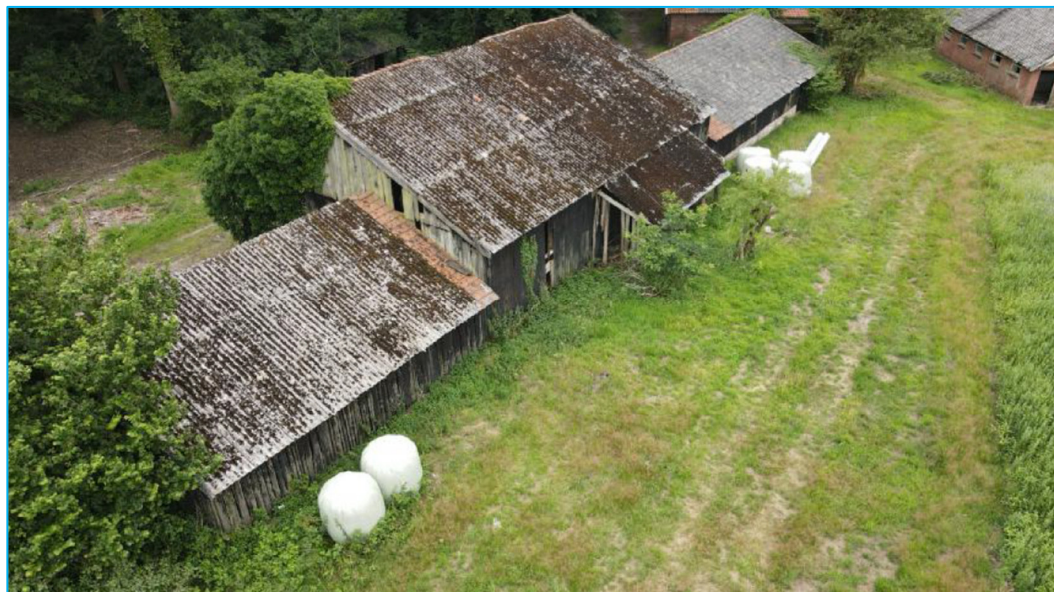
Foto 2: schuur met asbestdak
