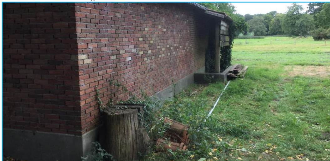
Foto 1: situatie vml. bovengrondse dieseltank
