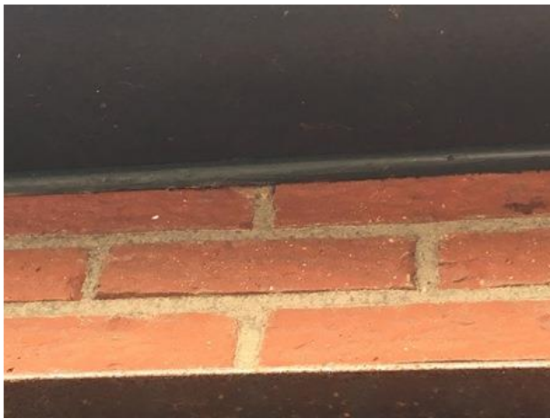
Strakke afwerking van de overstekbetimmering. Hierdoor kunnen vleermuizen de spouw niet bereiken.
