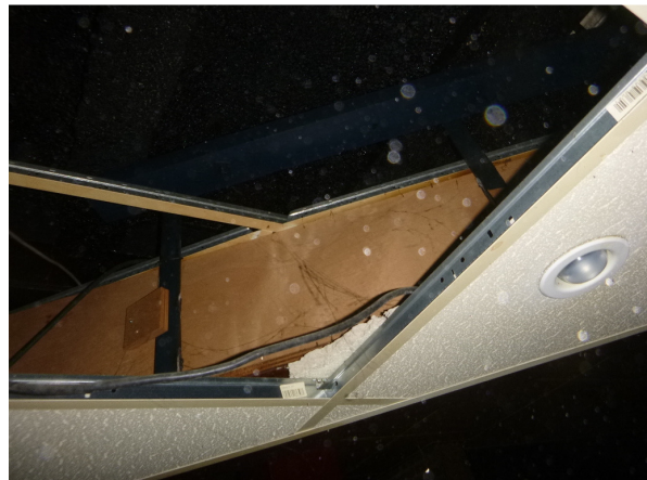
Inspectie boven systeemplafond
