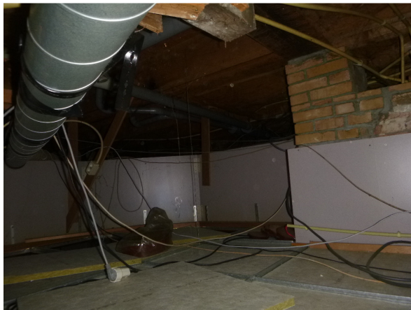
Inspectie boven plafond
