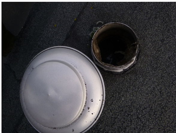
Inspectie doorvoer dak
