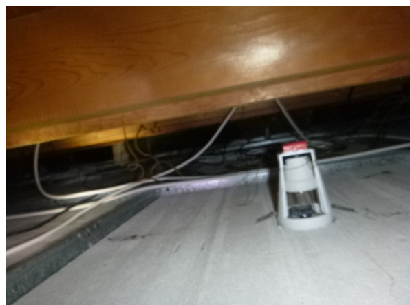
Inspectie boven systeemplafond
