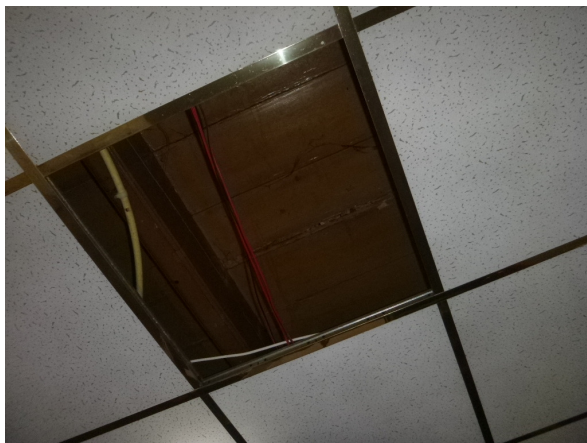
Inspectie boven systeemplafond
