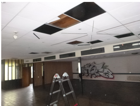
Inspectie boven systeemplafond
