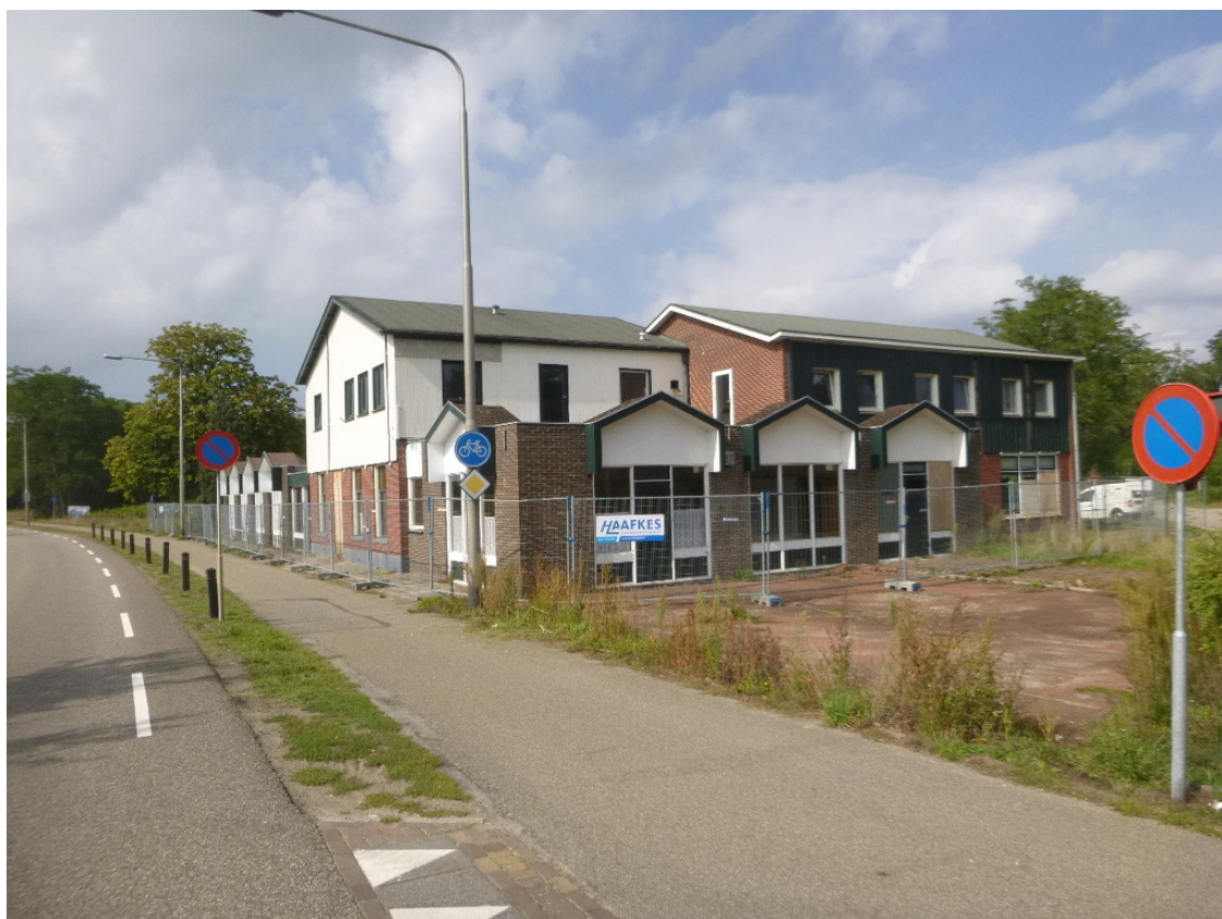
Het pand en de garage aan de Markeloseweg 80 te Goor
