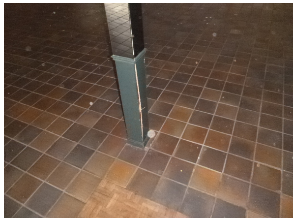
Inspectie beplating staander
