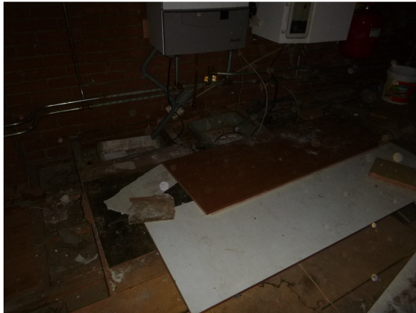
Beplating op zolder pand
