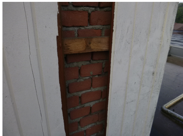
Inspectie achter plaatmateriaal
