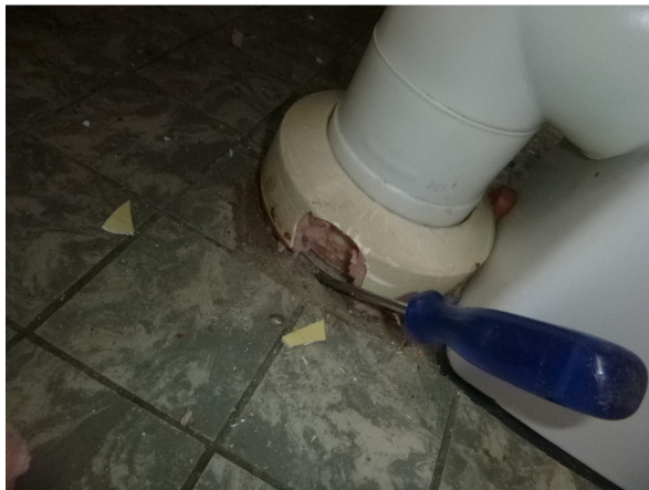
Inspectie afvoer toilet
