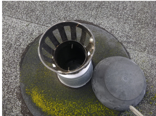
Inspectie doorvoer dak
