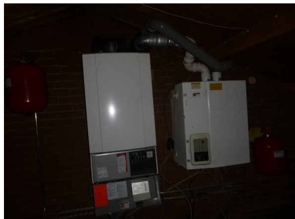
Asbestvrije cv-ketels op zolder pand
