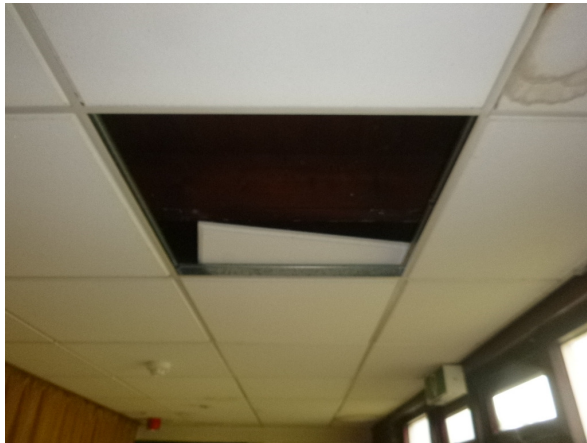
Inspectie boven systeemplafond
