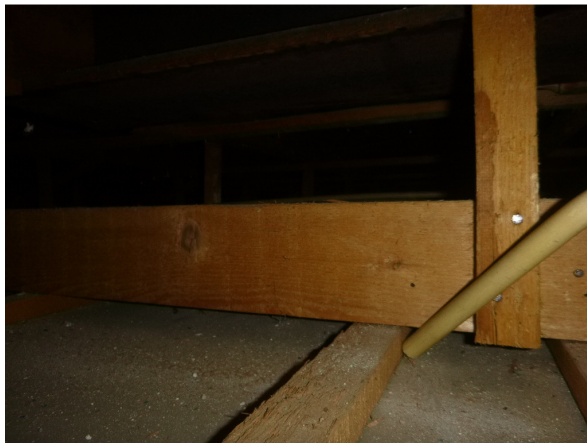
Inspectie boven plafond
