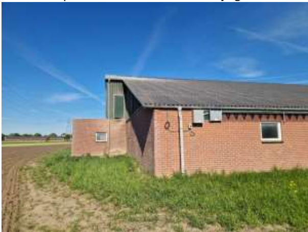
Figuur 12: Vml. chemische luchtwasser
