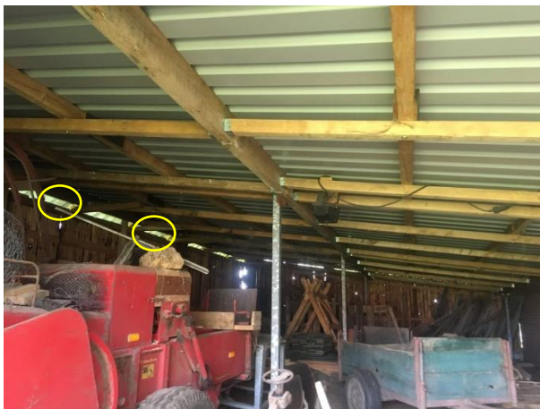
Kleine openingen onder het dakvlak (gele cirkels) zorgen ervoor dat de aanbouw toegankelijk is voor vogels.
