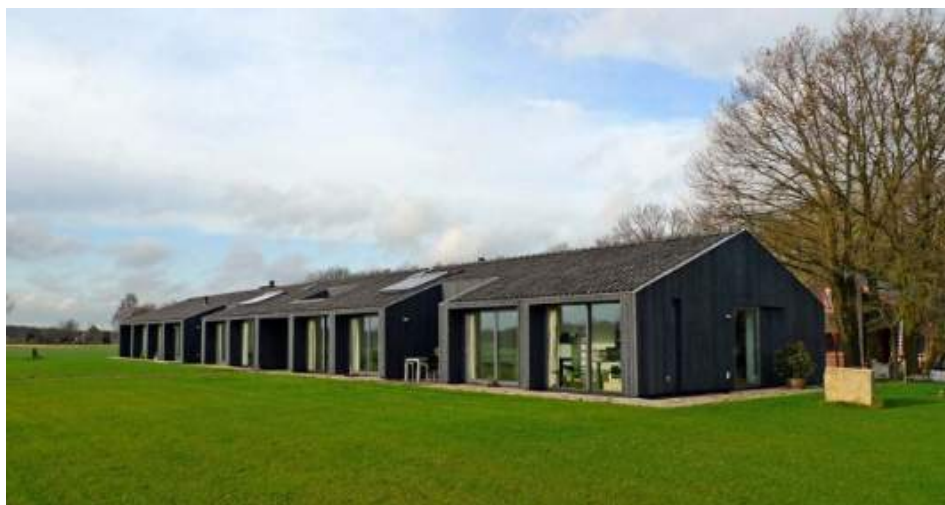
Afbeelding 18. Dubbele schuurwoning te Wesepe, door Ziegler-Branderhorst
