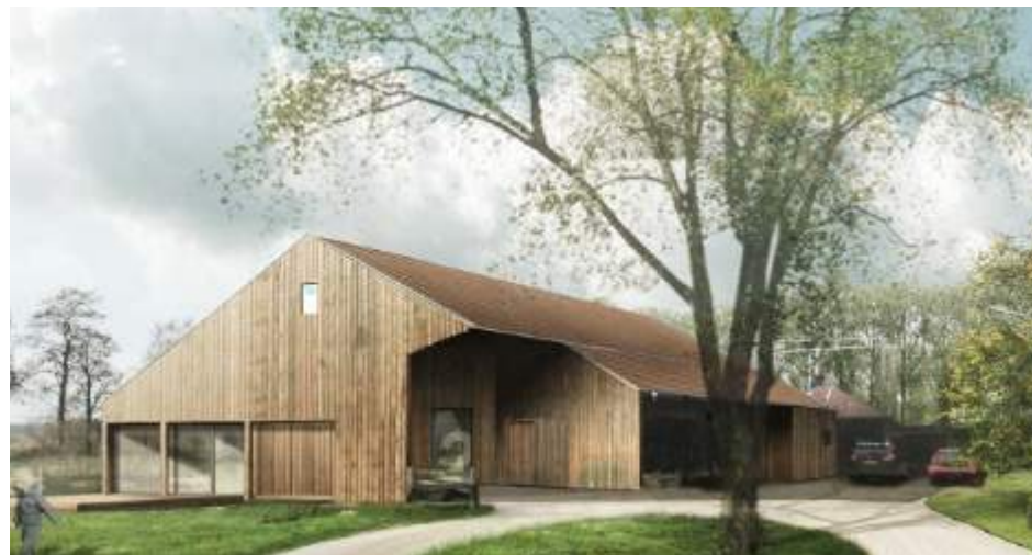
Afbeelding 14. Schuurwoning te Olst, door Ziegler-Branderhorst
