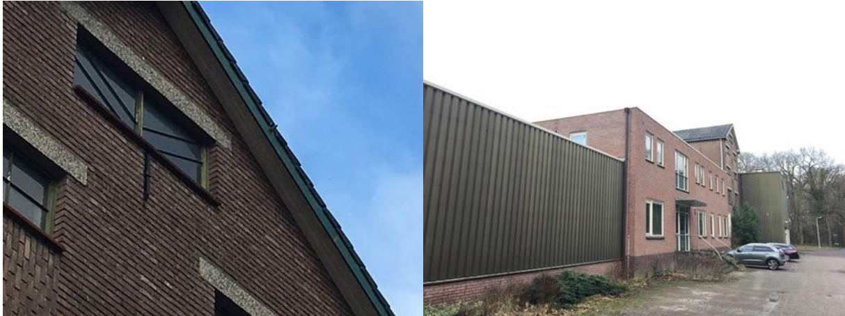
Detailopnames van het onderzochte gebouw.
