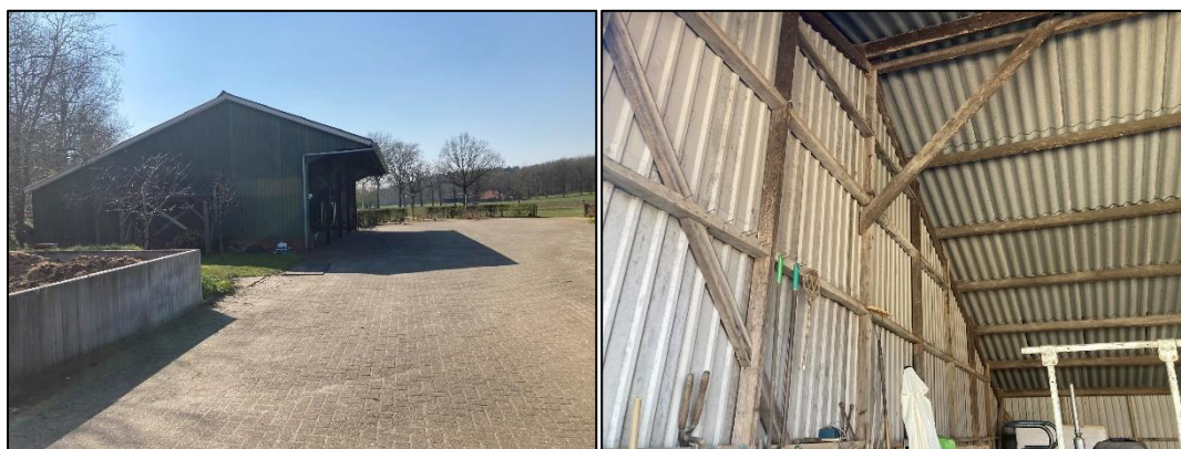
Figuur 2.3 (links): De oostzijde van de kapschuur, op de voorgrond ligt een sleufsilo voor de opslag van mest; Figuur 2.4 (rechts): De nok van de kapschuur. Er is geen dakisolatie, de kapschuur maakt ook van binnen een nieuwe en goed onderhouden indruk.
