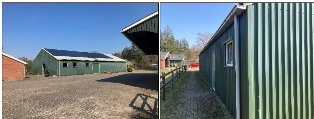
Figuur 2.12 (links): Een overzicht van de opslagschuur, gezien vanaf het zuidwesten. In de schuur staan werkmaterialen en auto's. Op het dak liggen kunststofplaten en zonnepanelen; Figuur 2.13 (links): Tussen het weiland en de opslagschuur bevindt zich een verharde steeg.
