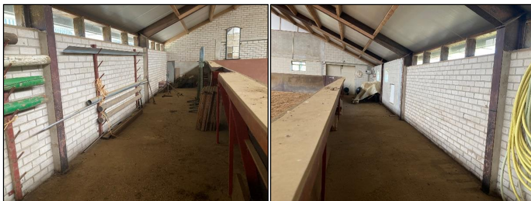
Figuur 2.9 (links): De binnenkant van de manege bestaat uit een rijbak met zand, waarlangs aan de oost- en westzijde materialen worden opgeslagen; Figuur 2.10 (rechts): De oostzijde van de materialenopslag in de manege.
