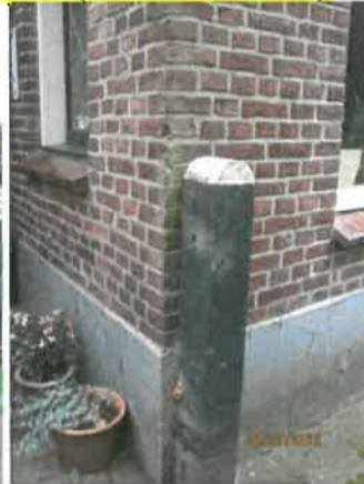
oorspronkelijke hekwerk van betonpalen met wit geschilderde koppen.
