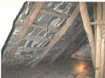
De overdekte mestplaats is bij de loopstal aangetrokken. Doorgezakte oplangers sporen kap. nageling panlatten.
