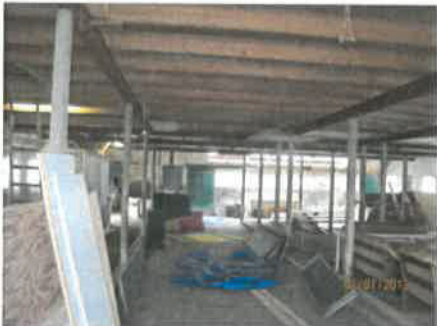
De overdekte mestplaats is bij de loopstal aangetrokken. Doorgezakte oplangers sporen kap. nageling panlatten.
