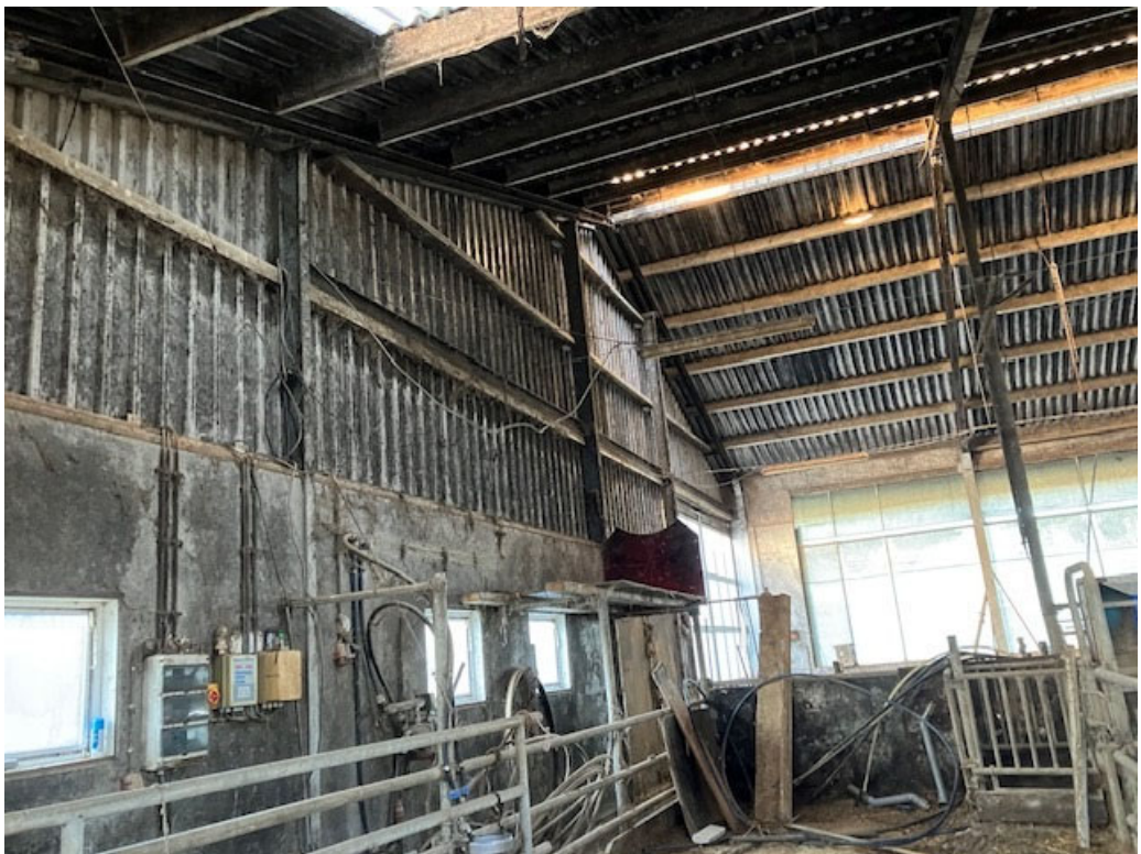
• Afbeelding 7: Ongeïsoleerde damwand en golfplaten
