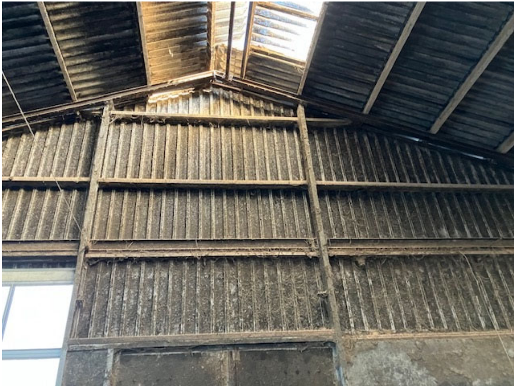
• Afbeelding 8: Ongeïsoleerde damwand en golfplaten
