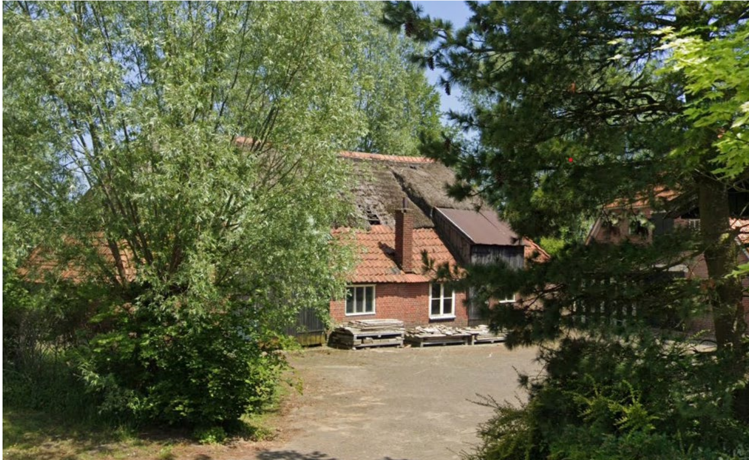
Karakteristieke schuur (Bron: google.com/maps )
