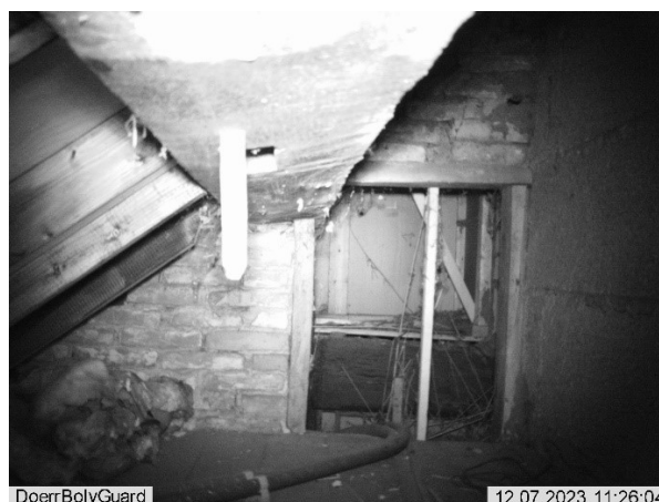
Foto 2: Camerabeeld op mogelijke rustplek steenmarter
