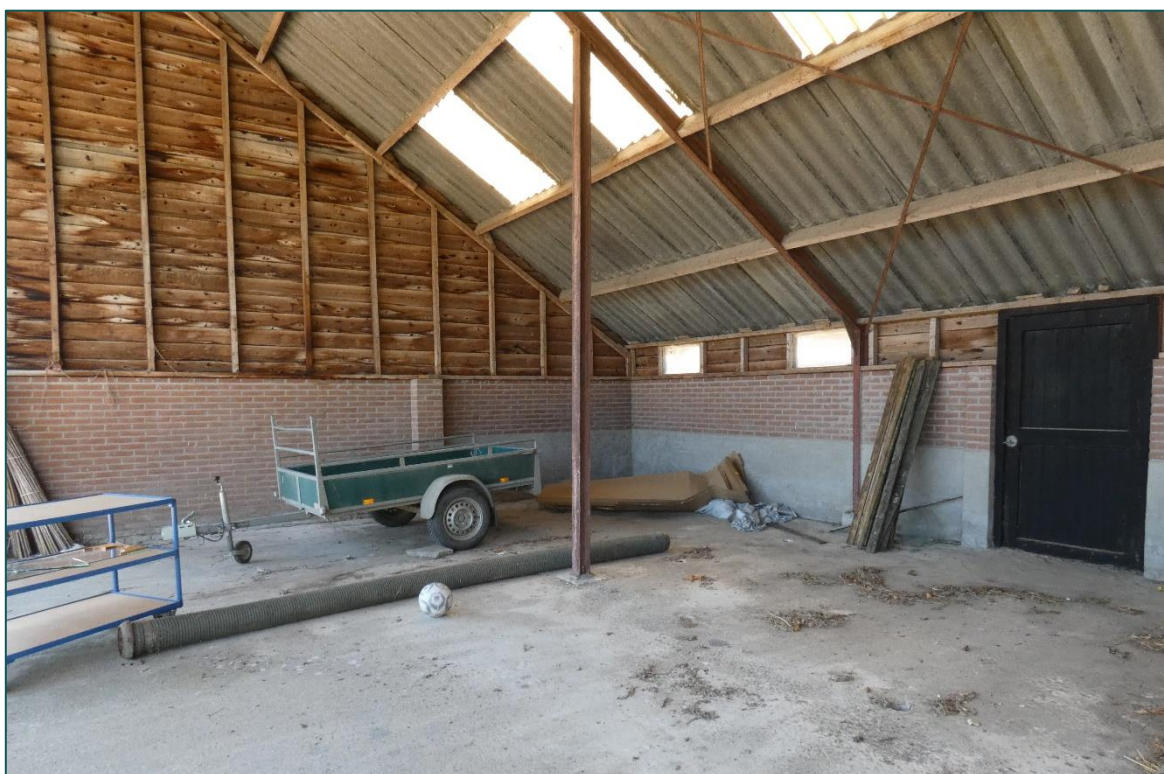
Figuur 3 De binnenzijde van de half open kapschuur (4).
