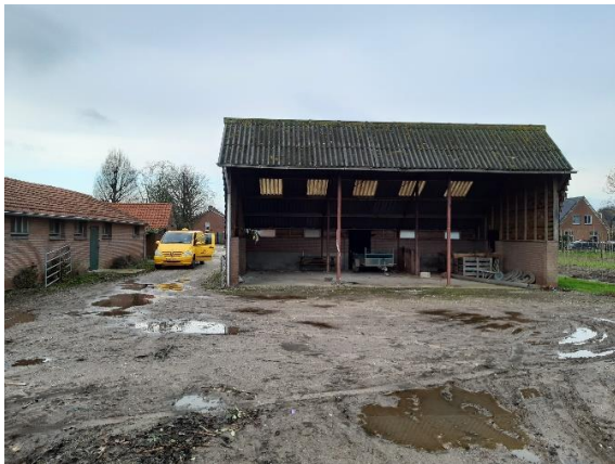
Foto 7: Schuur 3, gezien in noordwestelijke richting met de aanwezige dakgoot.
