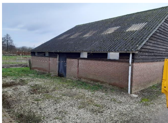
Foto 6: Schuur 3, gelegen achter de boerderij met de aanwezige dakgoot.
