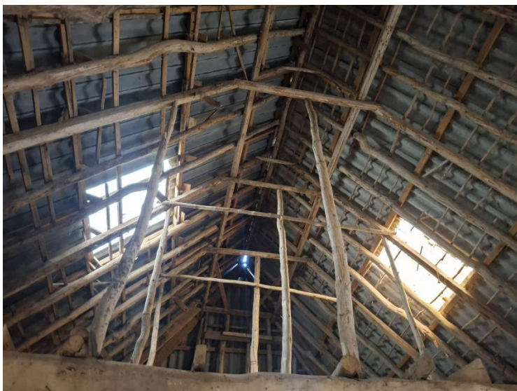
Figuur 2. Binnenzijde van de vloodschuur met asbest golfplaten.
