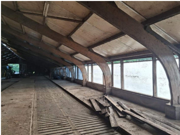
Figuur 3. Binnenzijde koeienstal met houten spanten en sandwichpanelen.
