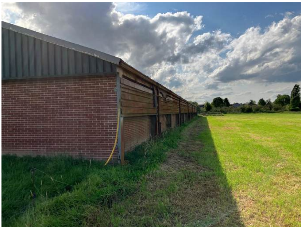
• Afbeelding 13: Zijgevel te slopen stal met naastgelegen grasland
