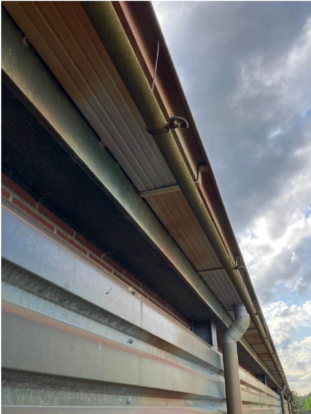
• Afbeelding 17: Onderzijde dakaansluiting te slopen stal
