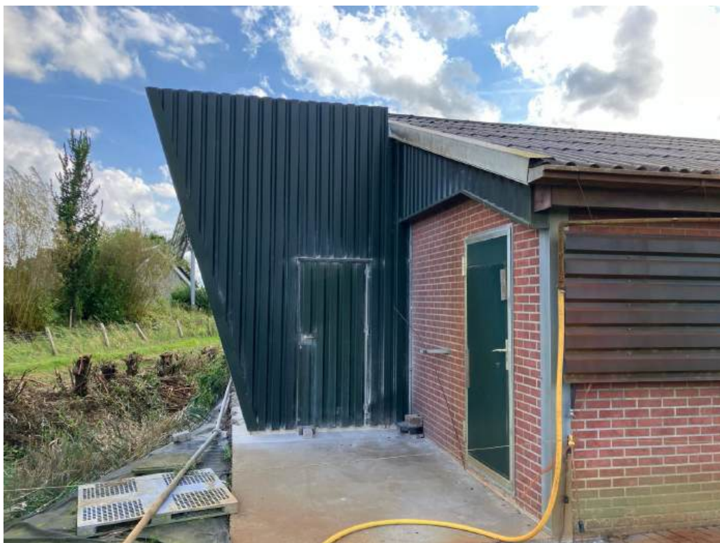
• Afbeelding 15: Achtergevel te slopen stal
