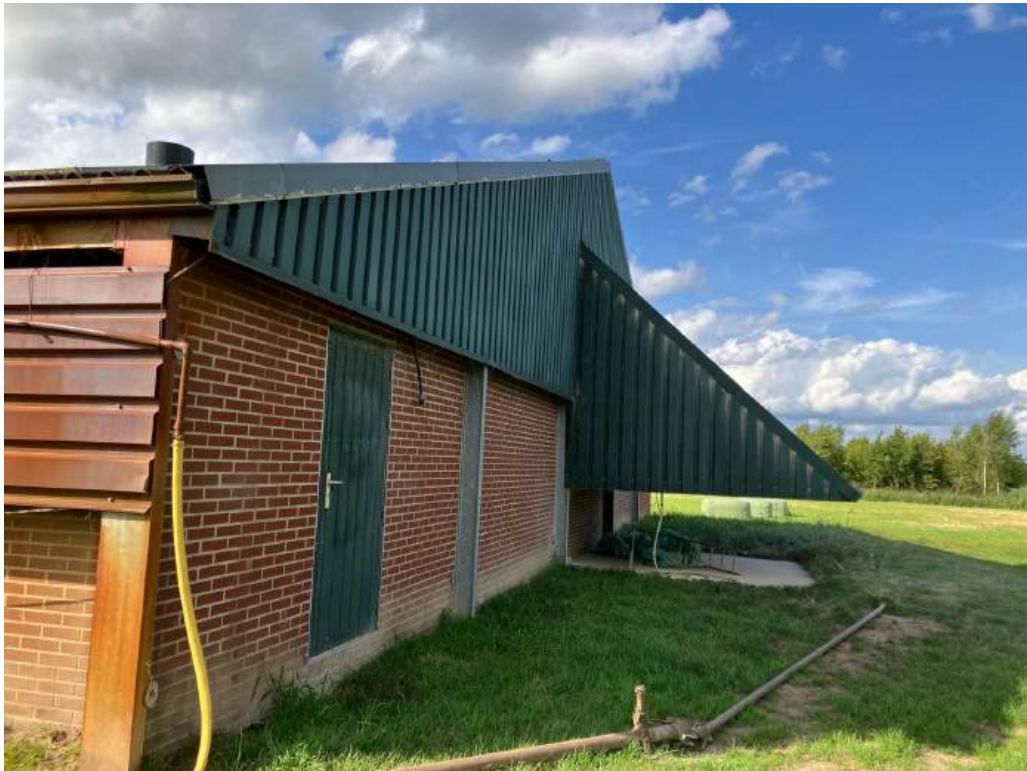
• Afbeelding 11: Achtergevel te slopen stal
