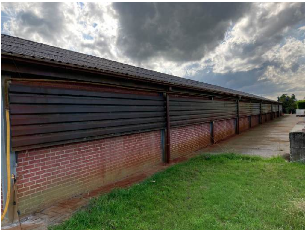
• Afbeelding 12: Zijgevel te slopen stal
