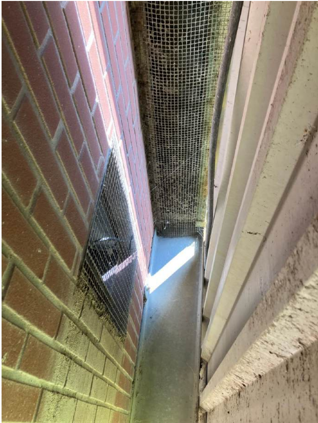
• Afbeelding 21: alle luchtinlaten afgesloten met vogelgaas
