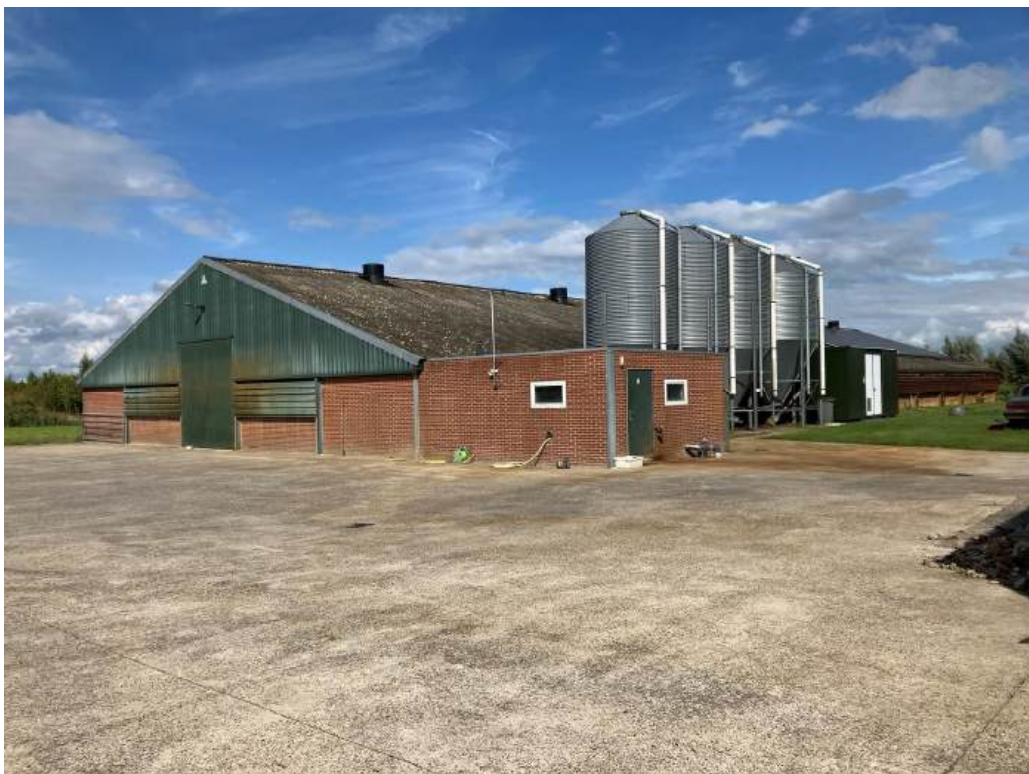
• Afbeelding 8: Voorzijde te slopen stal
