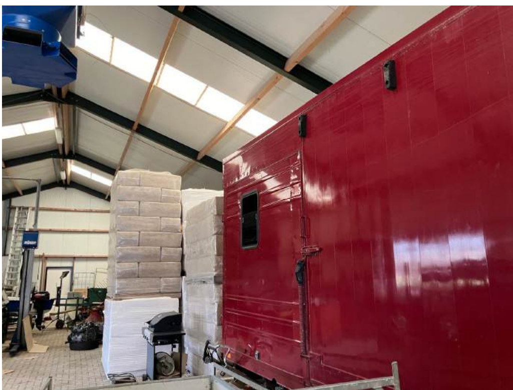
• Afbeelding 19: Binnenzijde loods, blijft behouden
