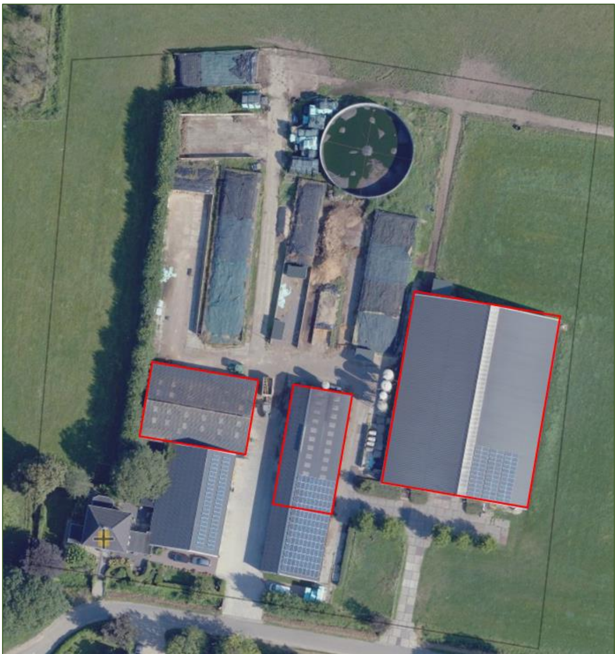
Figuur 3 Luchtfoto met de te slopen bebouwing (rood omlijnd)
