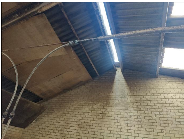
Foto: ruimte tussen golfplaten en dakbeschot is toegankelijk voor steenuil.
