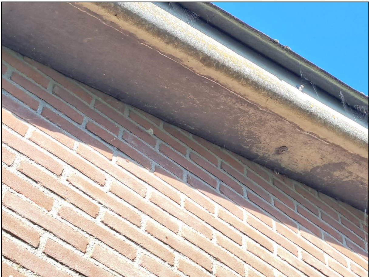
Detailfoto waarbij zichtbaar is dat de dak overstek nauw aansluit op het metselwerk.
