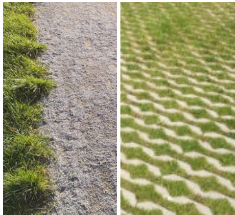
toepassen halfverharding of grasbetonstenen
