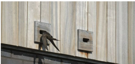
In de gevel geïntegreerde nestkasten
