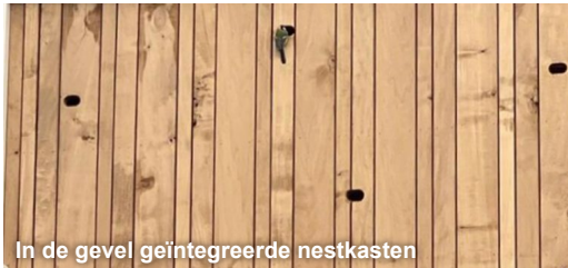
In de gevel geïntegreerde nestkasten
