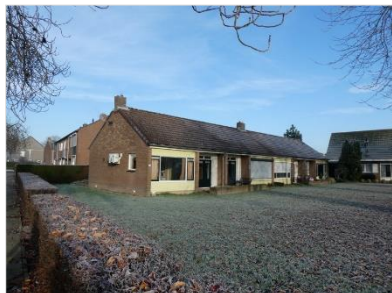
Figuur 2.6 Overzicht van de woningen aan de Hoofdstraat te Herveld.
