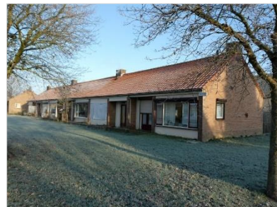
Figuur 2.8 Voorzijde van de woningen aan de Hessenbergstraat te Zetten.
