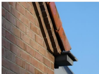
Figuur 5.8 Ruimte onder dakpannen van woningen aan de Hessenbergstraat te Zetten.
