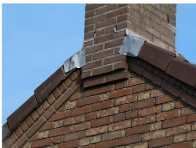
Figuur 5.7 Ruimte onder dakpannen van woningen aan de Hoofdstraat te Herveld.
