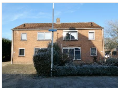
Figuur 2.9 Aanzicht van een van de woonblokken aan de Ploegstraat te Zetten.
