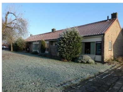
Figuur 2.8 Achterzijde van de woningen aan de Hessenbergstraat te Zetten.
