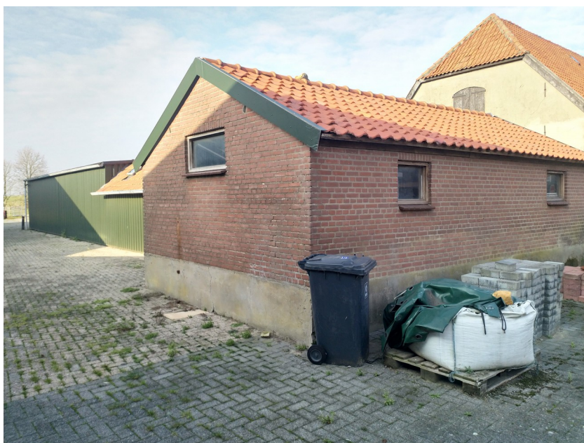
Achterzijde van de te slopen schuren. Op de achtergrond de woonboerderij die behouden blijft.
