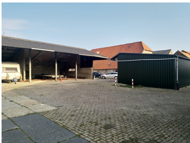
Afbeelding 2. Boerenerf met daarop de te slopen schuren te zien. Op de achtergrond de woonboerderij die behouden blijft.
