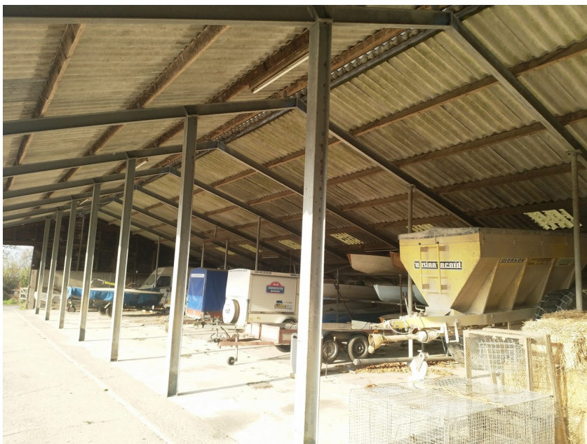
Binnenzijde van te slopen schuur zonder beschermde ecologische potenties
