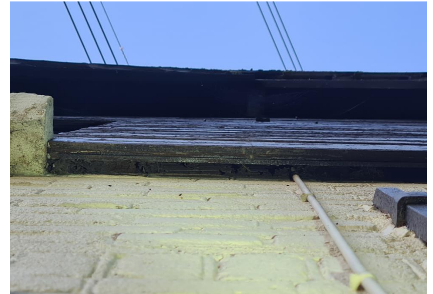
Figuur 11: Kieren achter gevelbetimmering
