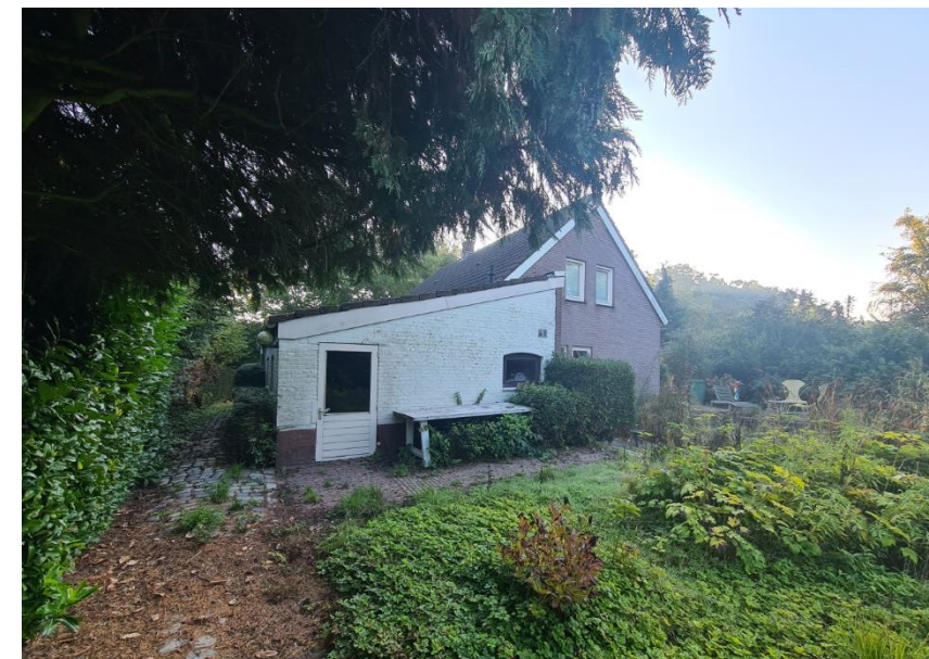
Figuur 4: Woning gezien vanuit het westen
