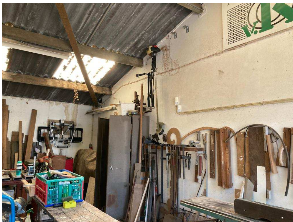
• Afbeelding 6: Binnenkant te slopen schuur 1
