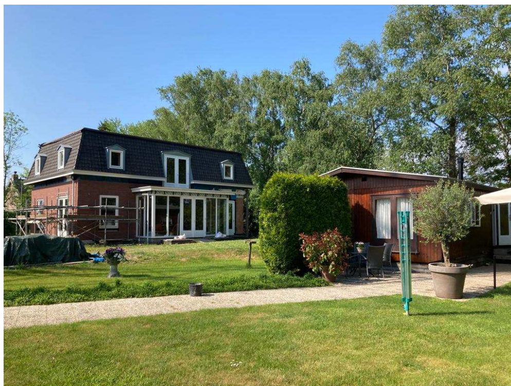
• Afbeelding 15: In aanbouw zijnde woning
