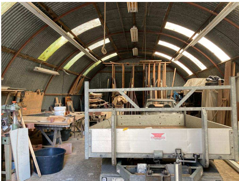
• Afbeelding 10: Binnenkant te slopen schuur 2
