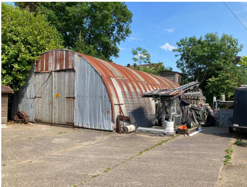
• Afbeelding 9: Voorkant te slopen schuur 2
