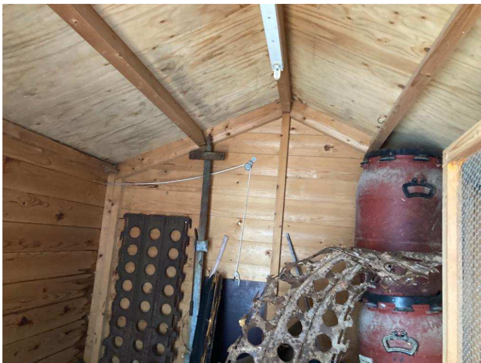
• Afbeelding 12: Binnenkant te slopen schuur 3
