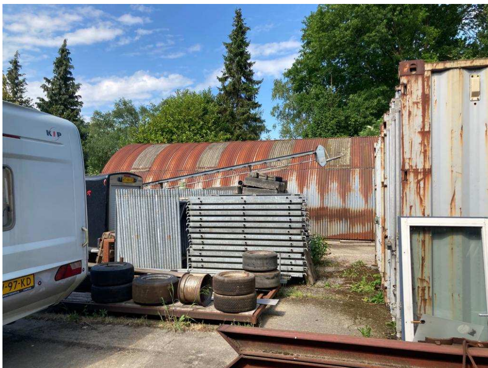
• Afbeelding 8: Zijaanzicht te slopen schuur 2
