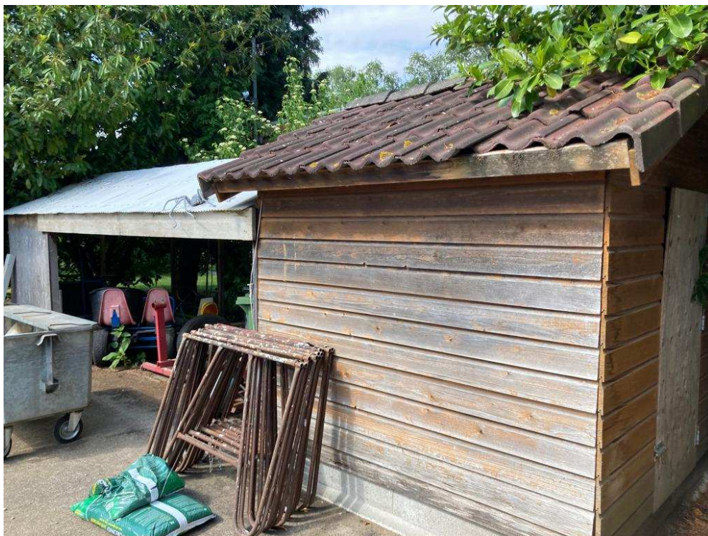
• Afbeelding 11: Te slopen schuur 3
