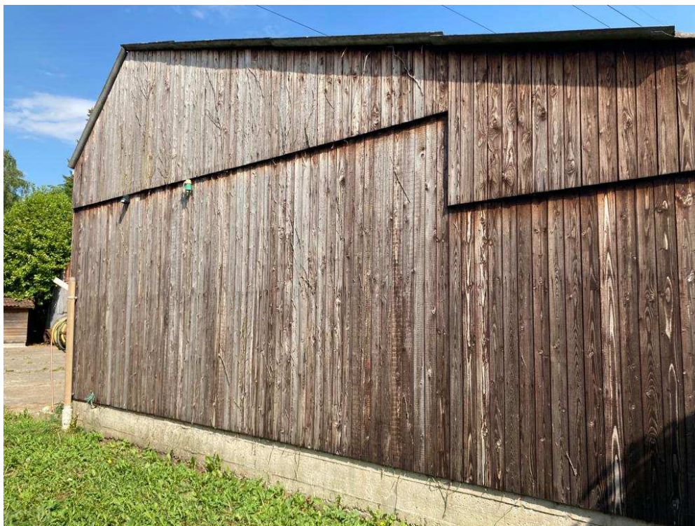
• Afbeelding 7: Zijkant te slopen schuur 1
