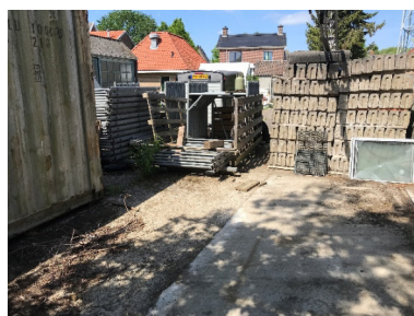
foto 8 / boring 13 richting west
