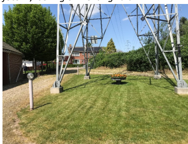
foto 5 / boring 07 richting west
