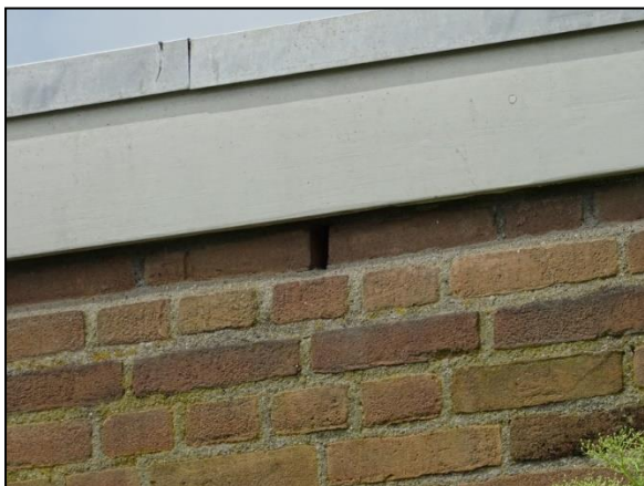
Figuur 9. Stootvoegen bieden ruimte tot de spouwmuur van het bijgebouw.
