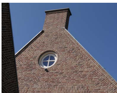
Schoorsteen als tuit van tuitgevel
