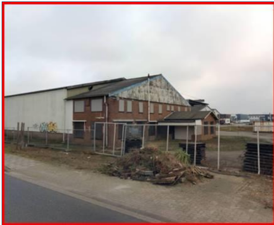
Figuur 4: Foto Handelsweg 3
