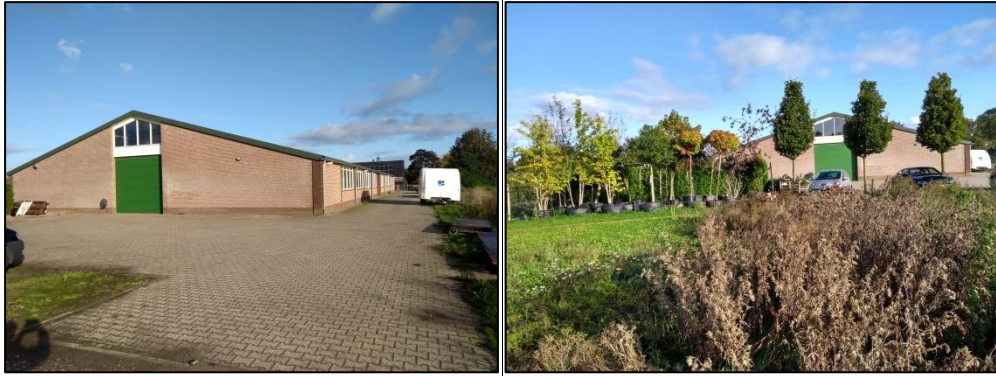
Ter hoogte van Groenestraat 7 staat een schuur (linker afbeelding) en ten zuiden van deze schuur een kleine boomkwekerij (rechts).
