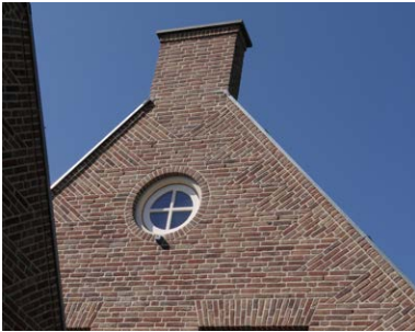
Schoorsteen als tuit van tuitgevel
