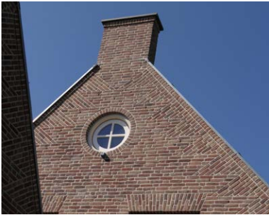
Schoorsteen als tuit van tuitgevel
