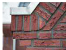
Metselwerk als gevelafwerking
