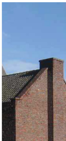
Schoorsteen op de hoeken
