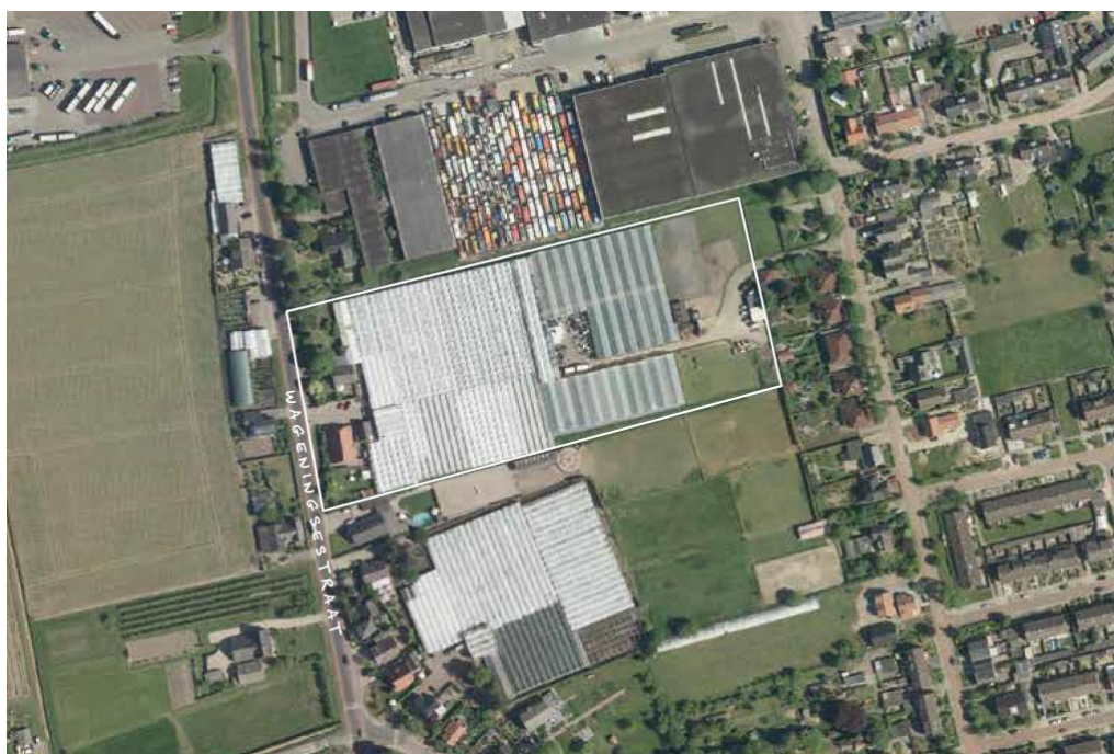
Figuur 2 Actuele situatie: kassencomplex
