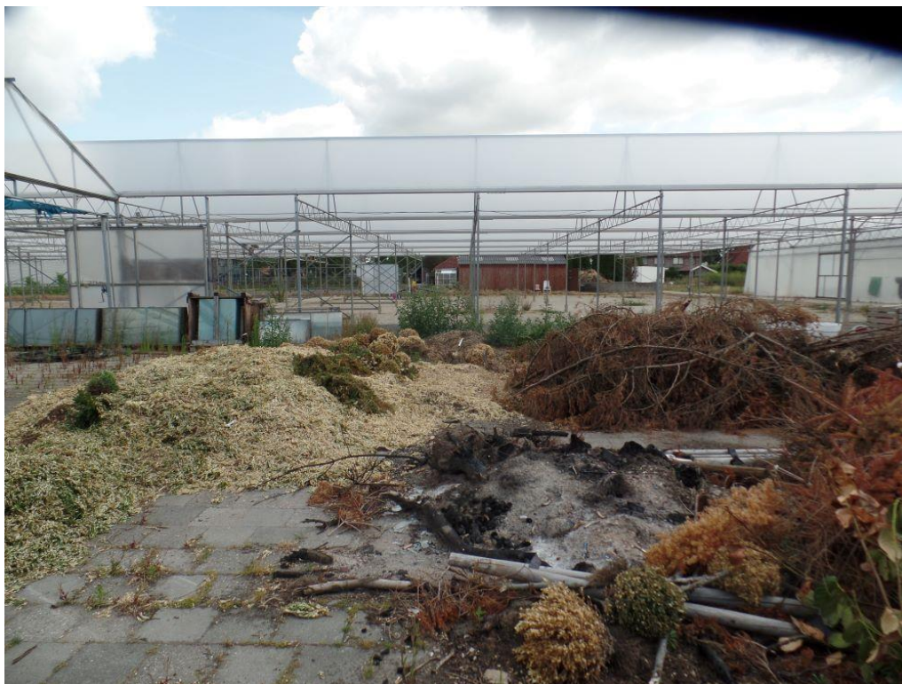
Figuur 5 Kassencomplex, deel gesloopt
