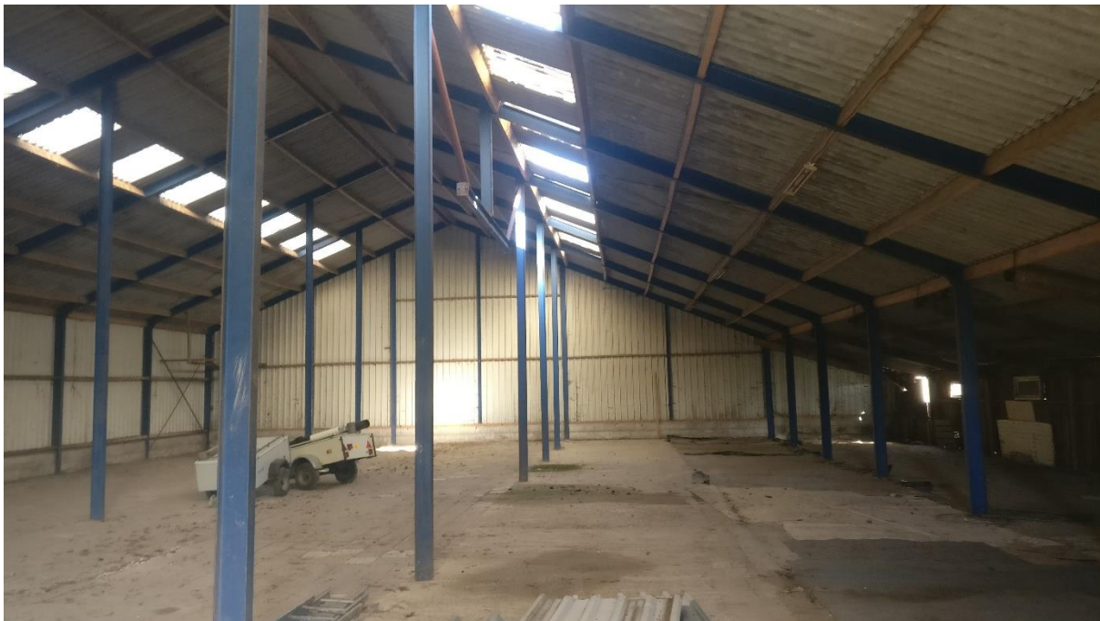
Figuur 7. Binnenkant schuur
